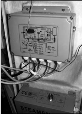
Установка электроблока (вид с задней стороны кабины).
