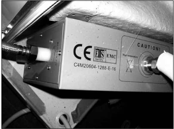
С помощью саморезов установите блок парогенератора на нижнюю деревянную закладную.
